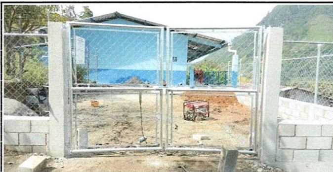
Foto 4: FINALIZACIÓN DE INSTALACIÓN DEL PORTÓN DE TUBO GALVANIZADO Y MALLA LEGÍTIMA
