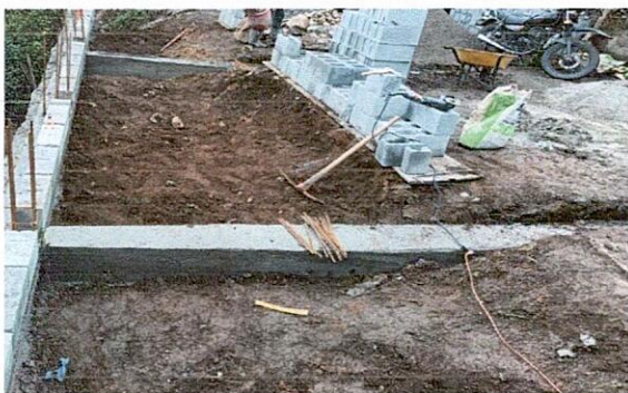
Foto 3: FINALIZACIÓN DE FUNDICIÓN DE CINCHOS PARA SUJERAR EL MURO DE CICLÓPEO
