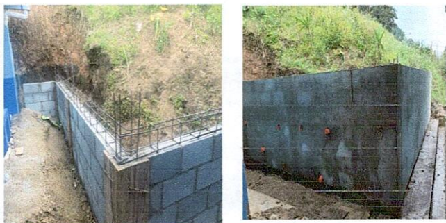
Foto 5: FINALIZACIÓN DE COLOCACIÓN DE BLOCK Y SERNIDO PARA EL MURO TRASERO DE LA ESCUELITA DE PREPRIMARIA
