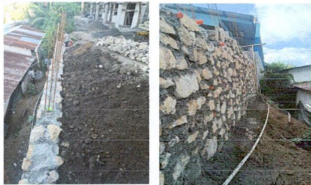
Foto 1: FINALIZACIÓN DE FUNDICIÓN DE BASES DE CONCRETO Y FUNDICIÓN DE MURO CICLÓPEO
